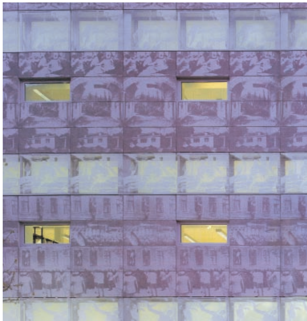
Acercamiento de la biblioteca en donde se aprecia un prisma compacto en el que apenas se distingue el bormigón de vidrio.
